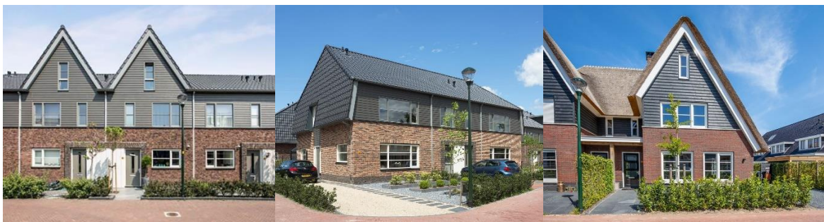
Referentiebeelden met hout of hout vervangend materiaal beklede gevels
